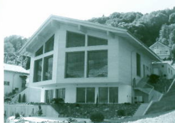
Unsere Klimaholzhäuser werden nach Minergie-P-Standard gebaut
