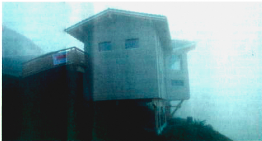
Das Holzhaus der Familie Waser ist mit dem Label Minergie-P-Eco zertifiziert.
