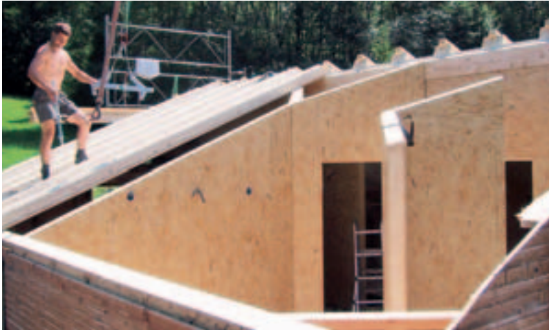
Bevor die Zimmerer die neuen Wand- und Dachelemente montieren konnten ...
