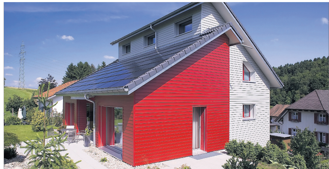
PRÄMIERT Der 2009 erstellte PlusEnergieBau in Vordemwald.
