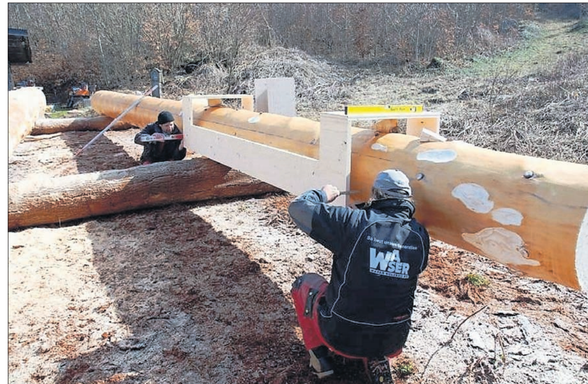
Präzisionsarbeit von Ruedi Hess mit Assistent Beat Flühler beim Anzeichnen der auszufräsenden Teile.
