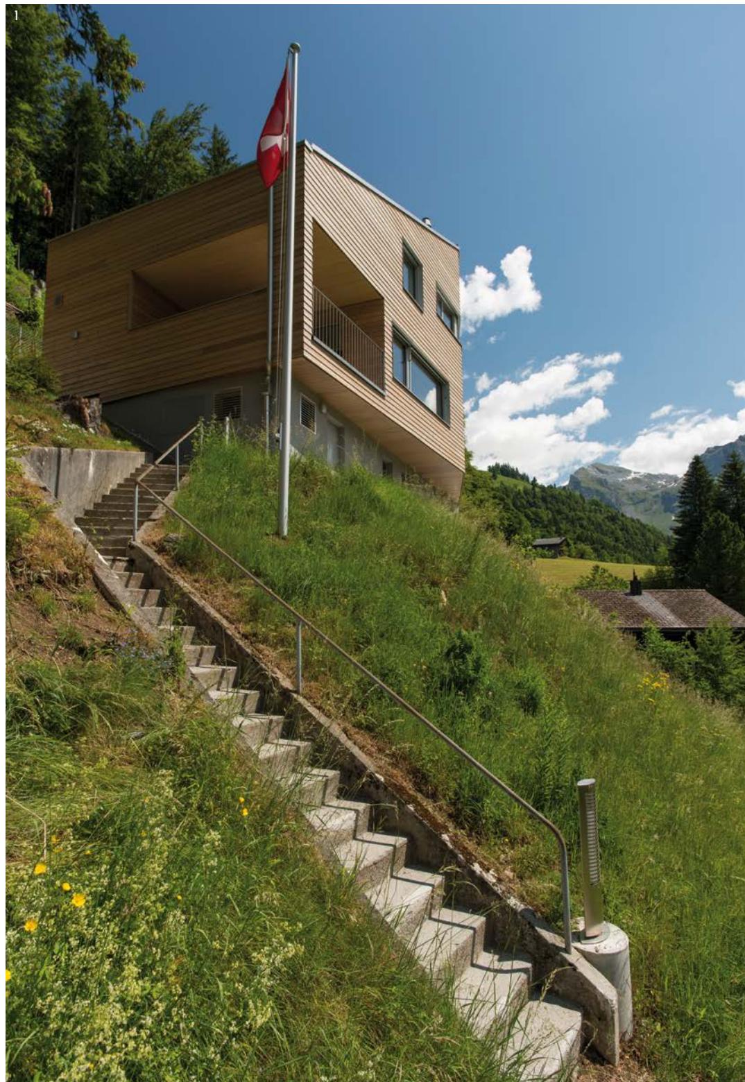
1 _Das Haus hat keine direkte Zufahrt und wird über einen Fussweg erschlossen. 2 _Ein Fassadenknick in der Dachfirstlinie dynamisiert den Bau und richtet ihn auf die Berglandschaft aus. Das Sockelgeschoss umfasst die Kellerräume und den Hauseingang.
