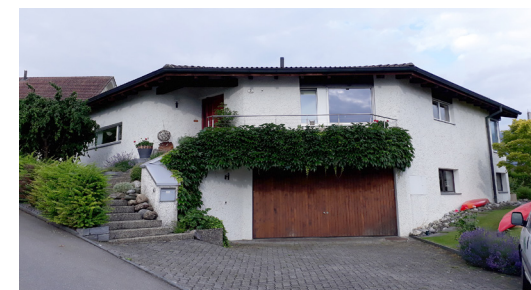
Das Einfamilienhaus vor Aufstockung.
