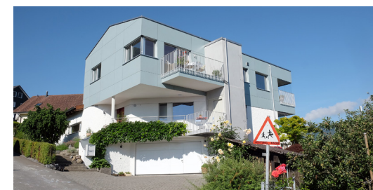
Aus dem Einfamilienhaus ist ein Zweifamilienhaus entstanden.
