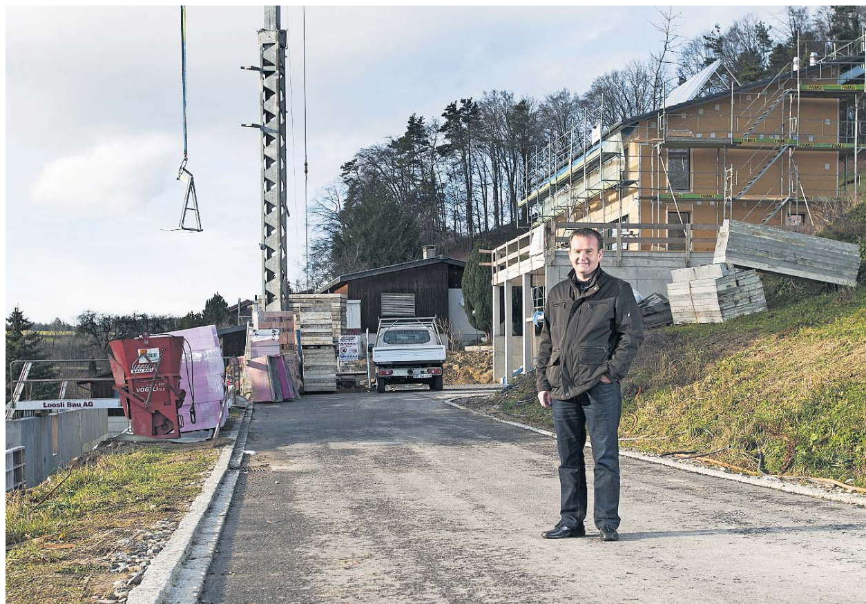
Gemeindeammann Thomas Häfliger vor der Baustelle des zweiten und dritten Hauses am Höhenweg. ABU
